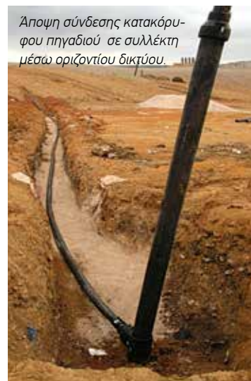
Άποψη κατακόρυφης γεώτρησης για εγκατάσταση διατήρητων αγωγού άντλησης βιοαερίου
